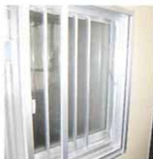
サッシの間に非常脱出面格子を取り付けて廊下側に出張るのを避けた。
