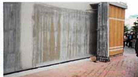
改修中（場所によっては壁で補強）
