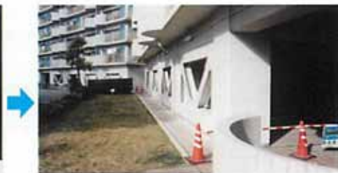
改修後（ブレースでしっかり補強）
