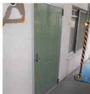
改修中：玄関まわり。ドアには新聞受けがあり、隙間風が入った。
