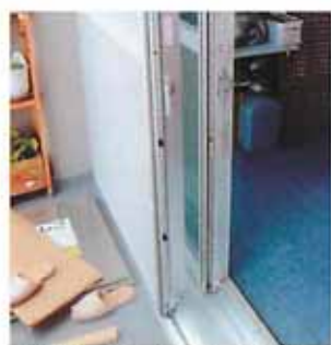
内側は既存のサッシをクリーニングして使用。外側には新しいサッシ。
