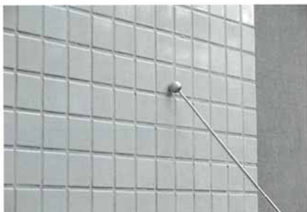
打検ハンマーによる打診検査
