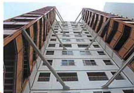
改修後（鉄骨階段を建物にしっかり固定）
