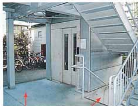
低層棟の1階踊り場はフラットに出来た スロープが無いと半階分は階段が残る
