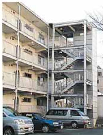
鉄骨造のエレベーターシャフトを設置した（低層棟）
